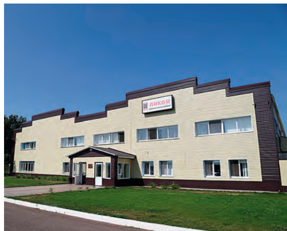
Офис и производственный корпус фабрики «Ликом» в городе Мелеуз (Республика Башкортостан).
